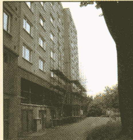
Lešení se objevilo také v Žitné ulici, kde byla zahájena kompletní rekonstrukce a sanace objektu panelového domu. Zanedlouho tak bude tento dům zdobit nová fasáda, dům bude kompletně zateplen kontaktním zateplovacím systémem. Akce bude financována investičním úvěrem s využitím dotace z programu Panel, o kterou družstvo již zažádalo.
