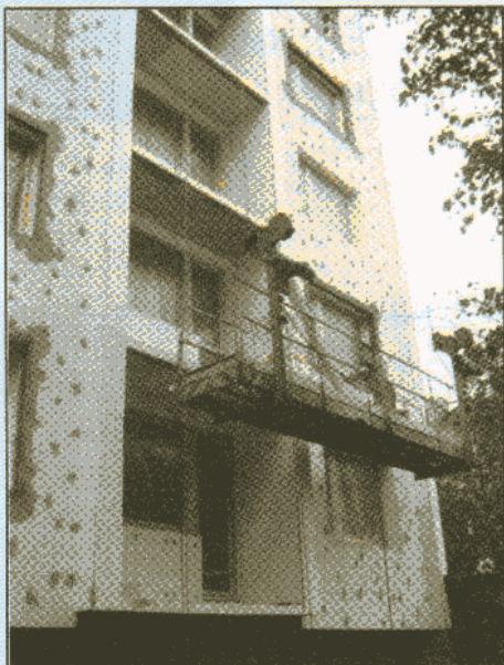
Stejně jako v případě ve Zhořelecké ulici (na snímku), je zateplování domů prováděno osvědčeným kontaktním zateplovacím systémem. Pro tuto investici bylo požádáno o dotaci z programu Panel.
