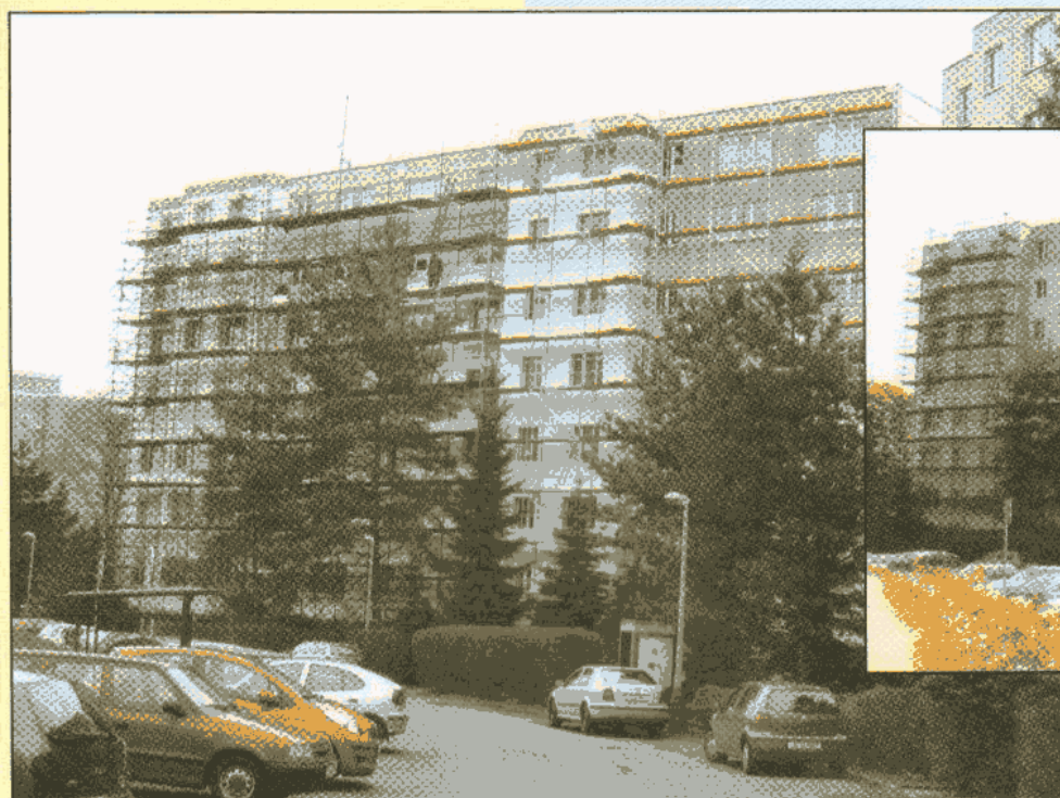
Stejně jako v případě ve Zhořelecké ulici (na snímku), je zateplování domů prováděno osvědčeným kontaktním zateplovacím systémem. Pro tuto investici bylo požádáno o dotaci z programu Panel.
