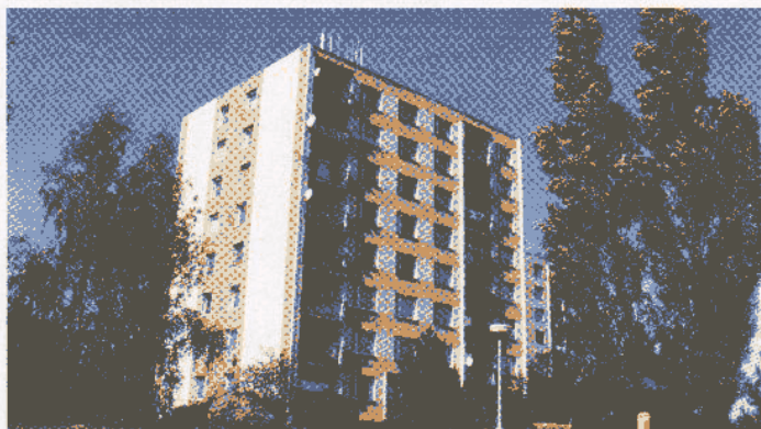
Zateplení domu v Olbrachtově ulici proběhlo již začátkem nového tisíciletí.
