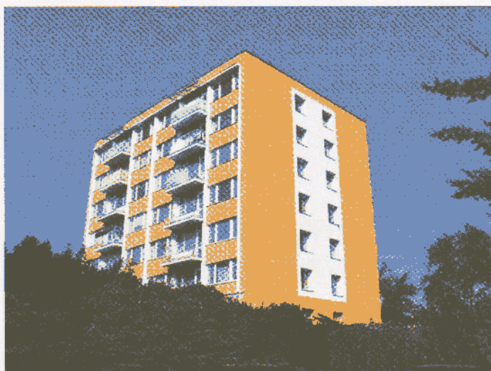
Za pomoci dotace z Programu Panel proběhla kompletní rekonstrukce a sanace společenství vlastníků jednotek Horní Kopečná, v Liberci-Rochlicích.
