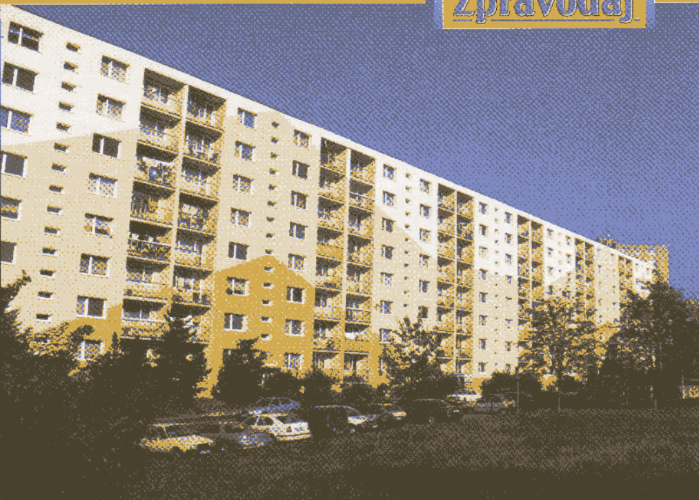
Kompletní sanace a rekonstrukce objektu ve Vlnašské ul. nákladem téměř 20 mil. Kč byla financována úvěrem od ČSOB. Realizaci provedla liberecká stavební společnost OSF 2000.
